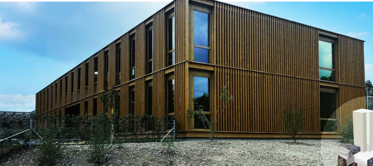
Construction d'une crèche
