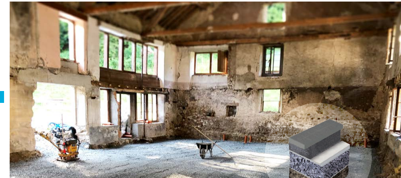
Rénovation d'une maison villageoise
