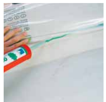
Raccord du freine-vapeur à une dalle en console avec pro clima ORCON F.
